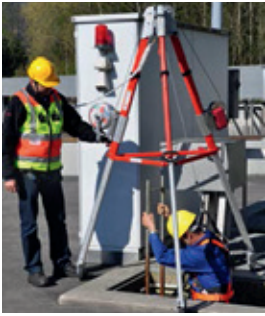
Sicherung einer Person beim Einstieg mit HSRG und Aufsichtsperson
