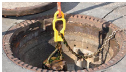
Heben von Pumpen mittels Pumpengreifstück
