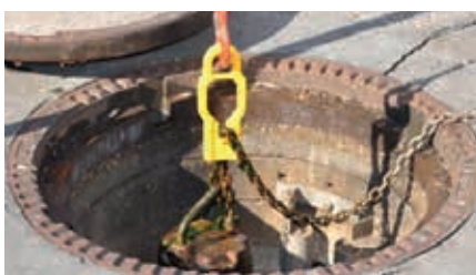
Heben von Pumpen mittels Pumpengreifstück
