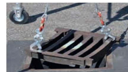
Lösen, Heben und Wegfahren von Kanaldeckeln (max. 500 kg) mit Lastwinde
