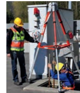
Sicherung einer Person beim Einstieg mit HSRG und Aufsichtsperson
